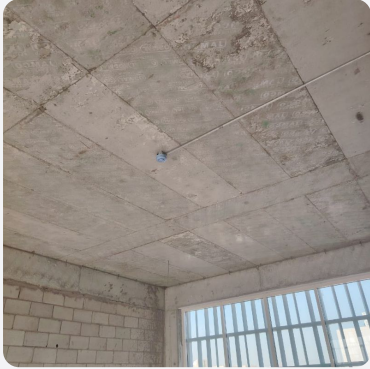
نظام إنذار ومكافحة الحريق - ت... 2026/01/24 02:03 PM
