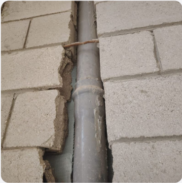
أعمال السباكة والتأسيس الصحي ... 2026/01/24 02:06 PM
