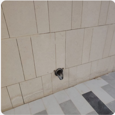
أعمال السباكة والتأسيس الصحي ... 2026/01/24 02:06 PM
