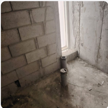
أعمال السباكة والتأسيس الصحي ... 2026/01/24 02:06 PM
