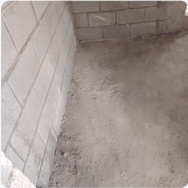
أعمال السباكة والتأسيس الصحي ... 2026/01/24 02:06 PM
