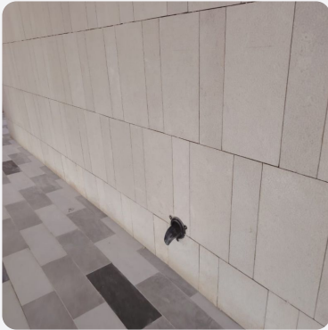
أعمال السباكة والتأسيس الصحي ... 2026/01/24 02:06 PM
