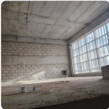
نظام إنذار ومكافحة الحريق - ت... 2026/01/24 02:03 PM
