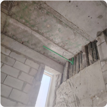
أعمال السباكة والتأسيس الصحي ... 2026/01/24 02:06 PM
