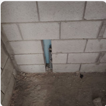
أعمال السباكة والتأسيس الصحي ... 2026/01/24 02:06 PM
