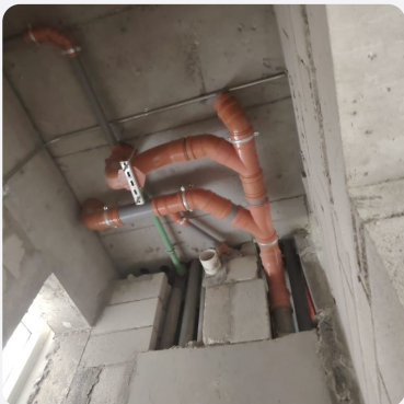
أعمال السباكة والتأسيس الصحي ... 2026/01/24 02:06 PM
