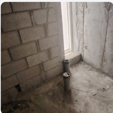
أعمال السباكة والتأسيس الصحي ... 2026/01/24 02:06 PM
