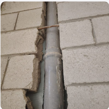
أعمال السباكة والتأسيس الصحي ... 2026/01/24 02:06 PM
