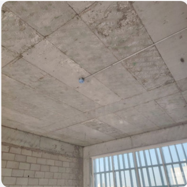
نظام إنذار ومكافحة الحريق - ت... 2026/01/24 02:03 PM
