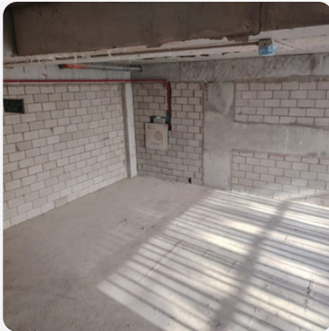
نظام إنذار ومكافحة الحريق - ت... 2026/01/24 02:03 PM
