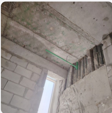
أعمال السباكة والتأسيس الصحي ... 2026/01/24 02:06 PM
