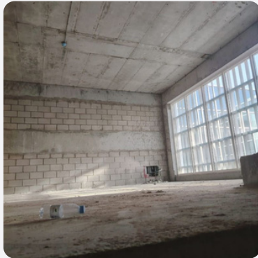
نظام إنذار ومكافحة الحريق - ت... 2026/01/24 02:03 PM
