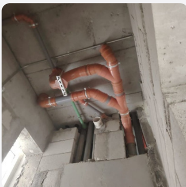
أعمال السباكة والتأسيس الصحي ... 2026/01/24 02:06 PM
