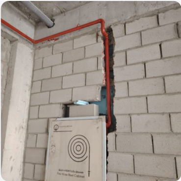
نظام إنذار ومكافحة الحريق - ت... 2026/01/24 02:03 PM
