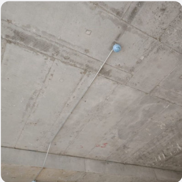
نظام إنذار ومكافحة الحريق - ت... 2026/01/24 02:03 PM
